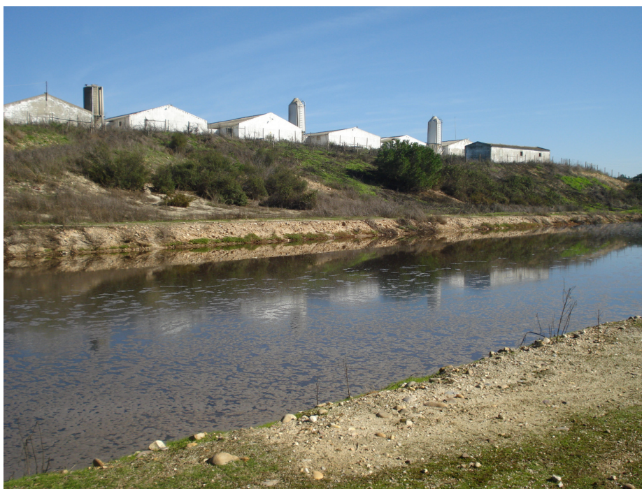
Figura 7 - Lagoa de retenção com o bordo livre de 0,5 m.
